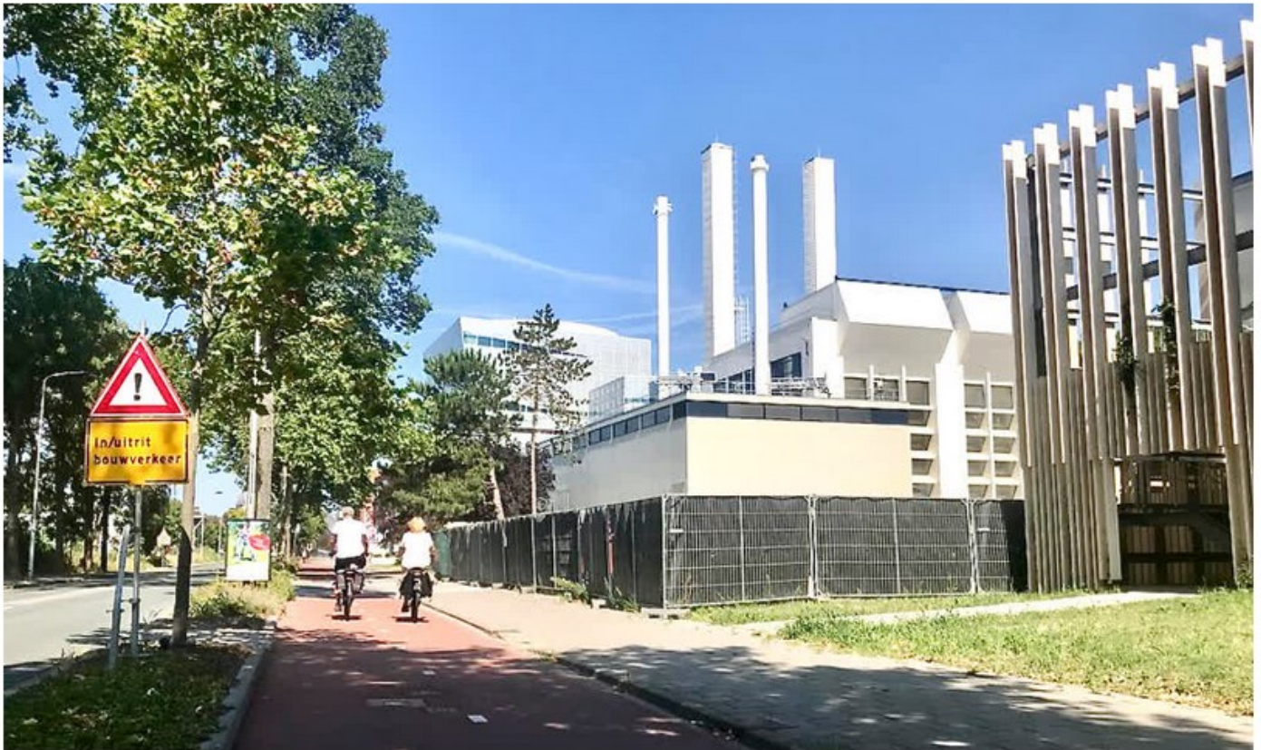
Locatie Geothermie Rotterdamseweg
