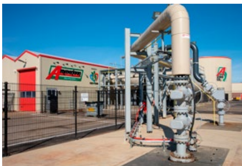
Aardwarmte is water van ruim zeventig graden dat wordt opgepompt uit de bodem. Het gaat na gebruik weer terug de bodem in.
